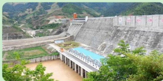
Hình 3. Cụm công trình đầu mối thủy điện Sơn La
